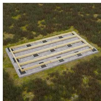
Efter detta är det bra att göra ett galler (tåligt material) ovanpå betongplattorna (bild nedan) som gör det enklare att få modulerna på samma nivå.
