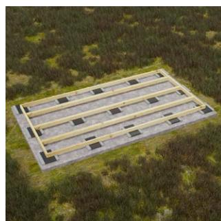
Daarna maakt u best een rooster (duurzaam materiaal) op de betonplaten (afbeelding onderaan). Op die krijgt u de modules makkelijker op eenzelfde niveau.
