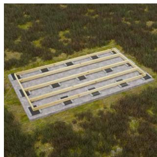
Après quoi, il est recommandé de réaliser une trame (matériau durable) par-dessus les dalles de béton (voir illustration ci-dessous) pour que les modules puissent être placés plus facilement au même niveau.
